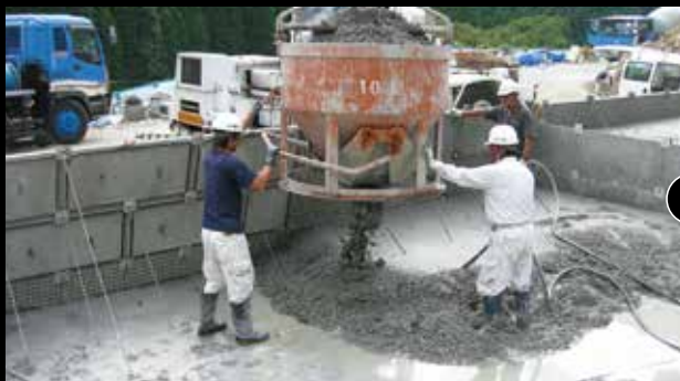
05: コンクリート打設状況
