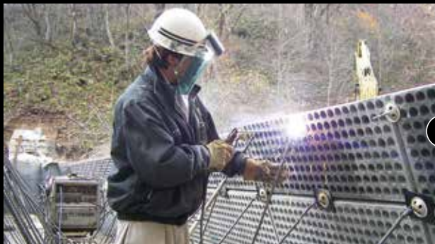
03: セパレーター溶接状況
