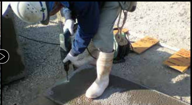
04: 補強金具取付穴加工状況
