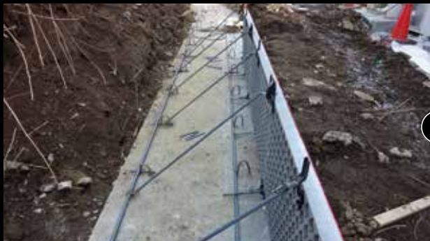
01: 1 段目組立状況
