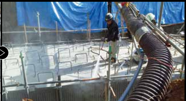
06: グリーンカット状況
