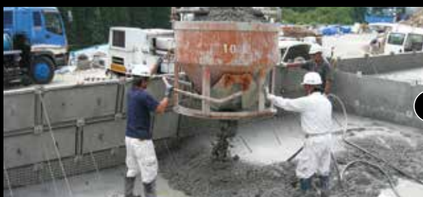
05: コンクリート打設状況
