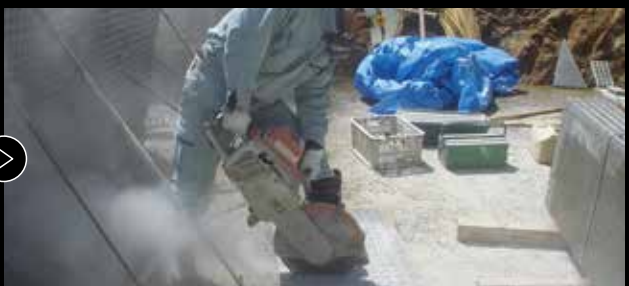
04: 型枠パネル切断加工状況
