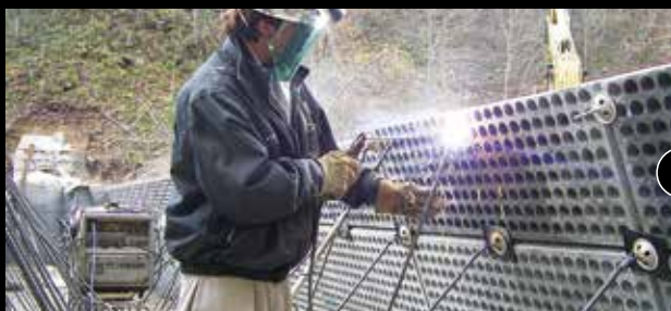
03: セパレーター溶接状況
