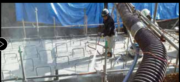
06: グリーンカット状況
