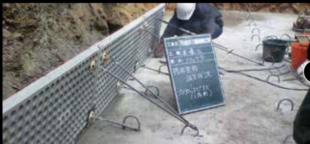
01: 1段目組立状況
