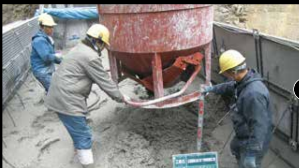
05: コンクリート打設状況
