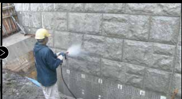
06: 打設後、洗浄状況
