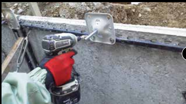
03: 専用組立部材取付状況
