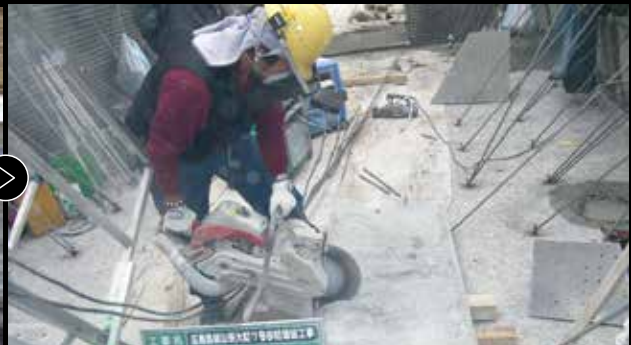
04: 型枠パネル切断加工状況
