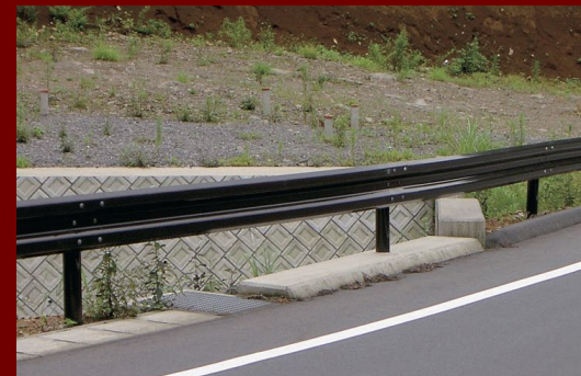
ガードレール工事
