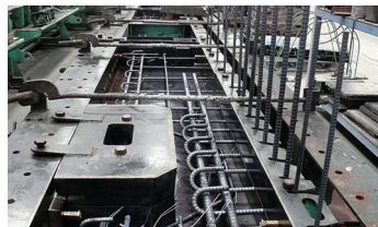
PC基礎製造ライン
