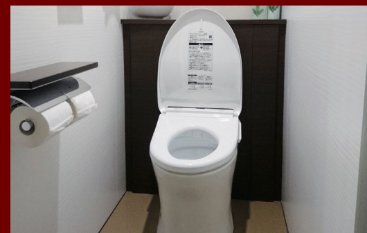
トイレ取付工事
