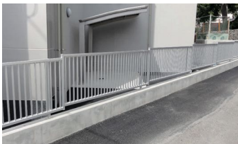
フェンス工事
