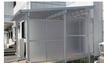
通路目隠し工事
