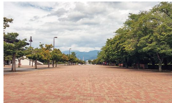
インターロッキング完成現場
