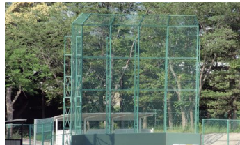
バックネット取付工事
