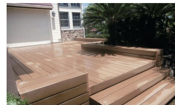
ウッドデッキ工事
