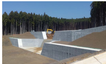
砂防完成現場
