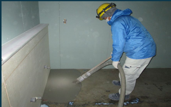
エスレベル打設状況
