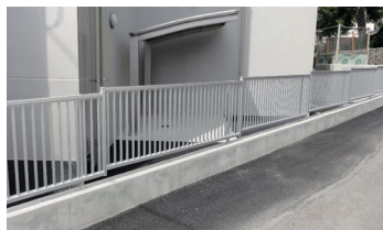
フェンス工事
