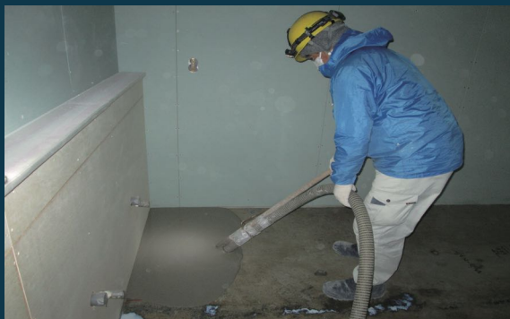
エスレベル打設状況
