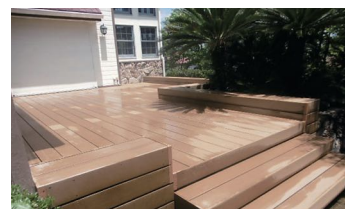
ウッドデッキ工事
