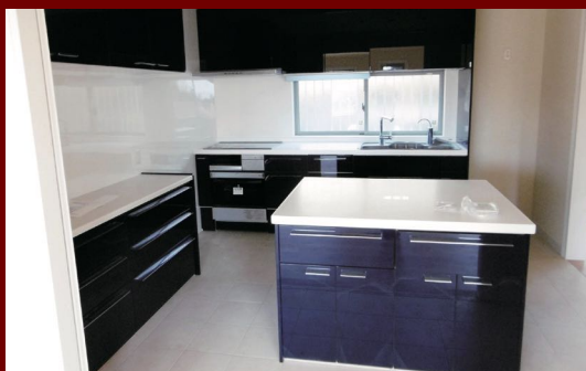
キッチン取付工事
