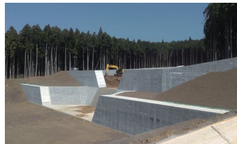
砂防完成現場
