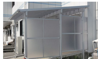
通路目隠し工事
