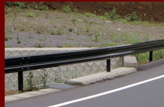
ガードレール工事
