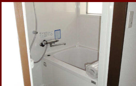
ユニットバス取付工事
