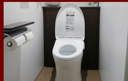
トイレ取付工事
