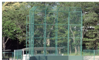
バックネット取付工事
