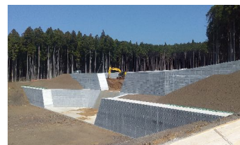
砂防完成現場
