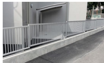
フェンス工事
