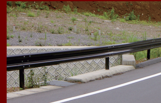
ガードレール工事
