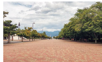
インターロッキング完成現場
