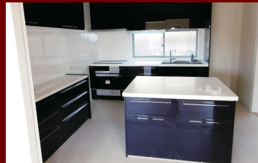
キッチン取付工事
