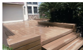
ウッドデッキ工事
