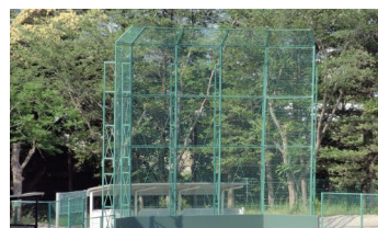
バックネット取付工事
