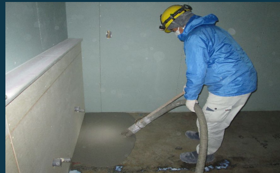
エスレベル打設状況
