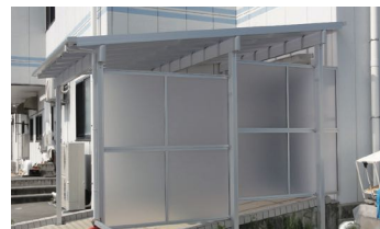
通路目隠工事
