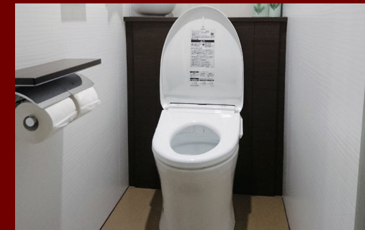
トイレ取付工事
