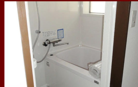
ユニットバス取付工事
