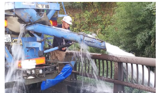
災害時における消防用水等の確保
