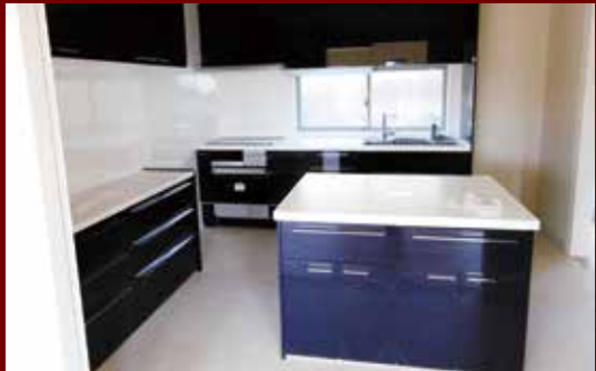
キッチン取付工事
