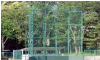
バックネット取付工事
