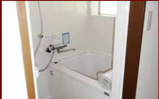
ユニットバス取付工事
