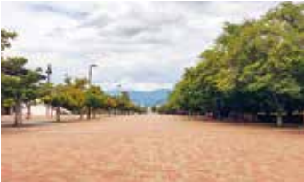
インターロッキング完成現場
