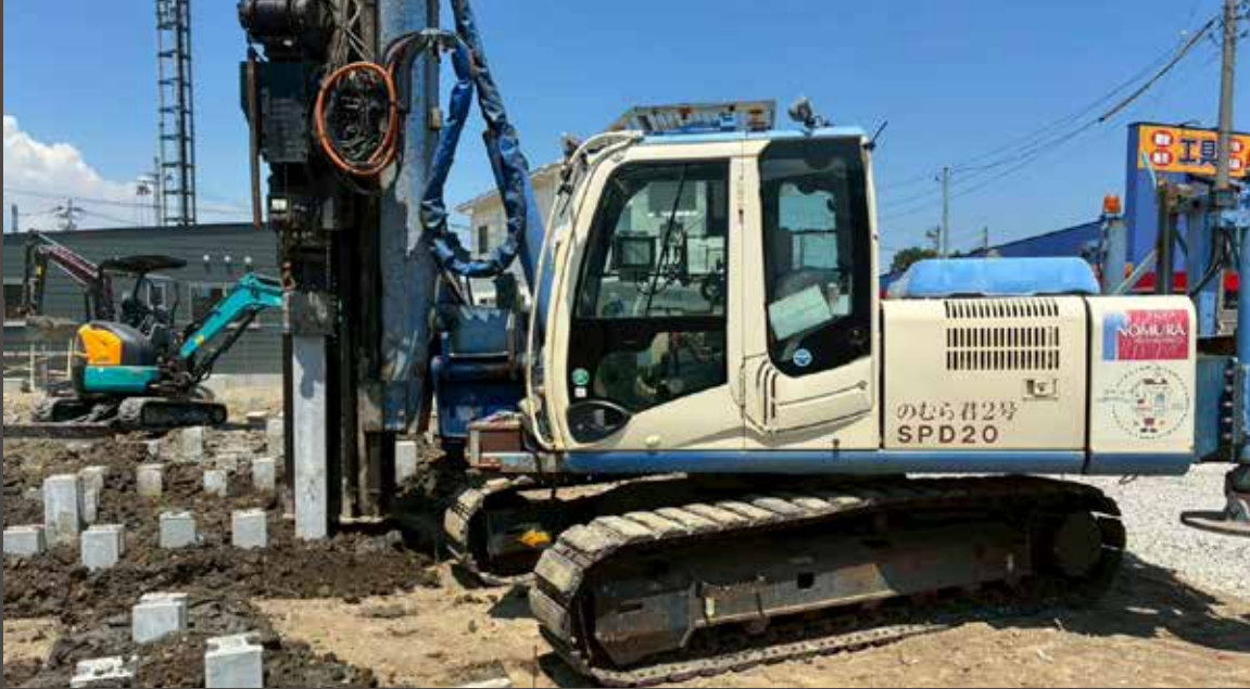
H パイル工事
