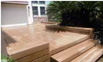
ウッドデッキ工事
