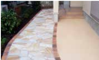
タイル&洗い出し工事
