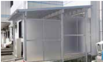
通路目隠工事
