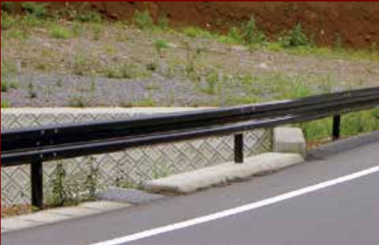
ガードレール工事
