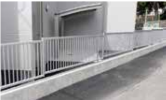
フェンス工事
