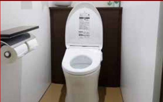
トイレ取付工事
