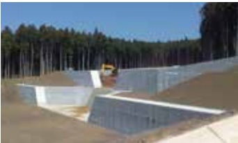
砂防完成現場
