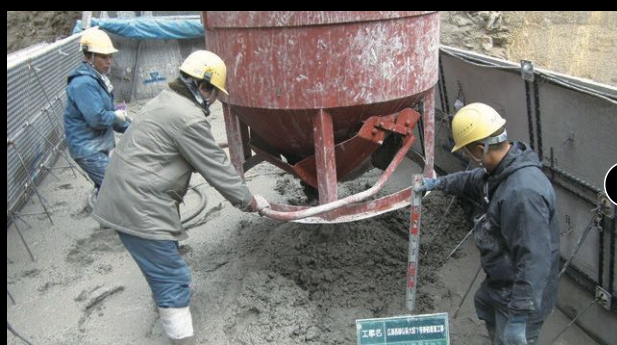
05: コンクリート打設状況
