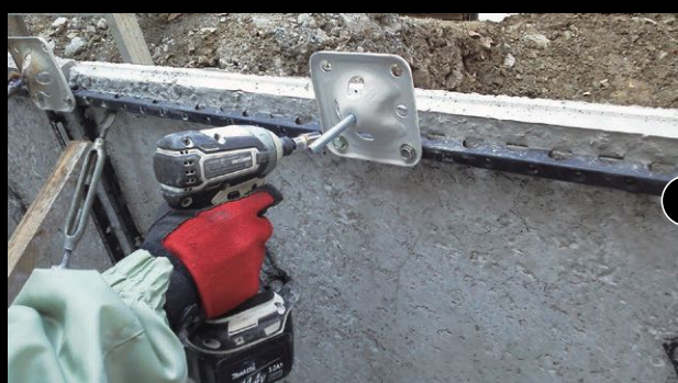
03: 専用組立部材取付状況
