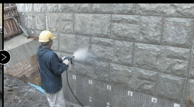
06: 打設後、洗浄状況
