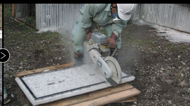
04: 型枠パネル切断加工状況
