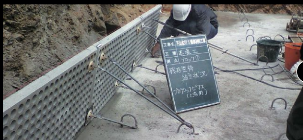
01: 1段目組立状況
