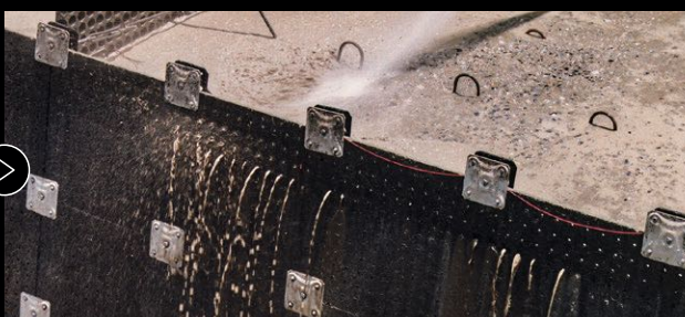
06: グリーンカット状況
