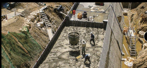
05: コンクリート打設状況
