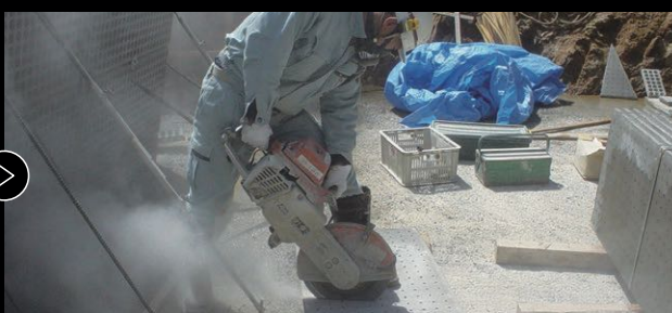
04: 型枠パネル切断加工状況
