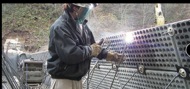
03: セパレーター溶接状況
