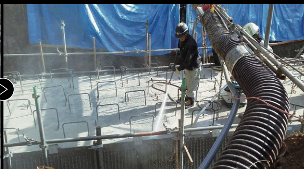
06: グリーンカット状況
