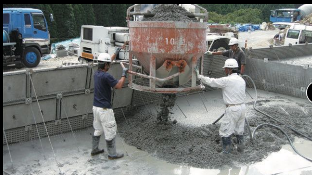
05: コンクリート打設状況
