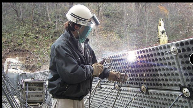
03: セパレーター溶接状況
