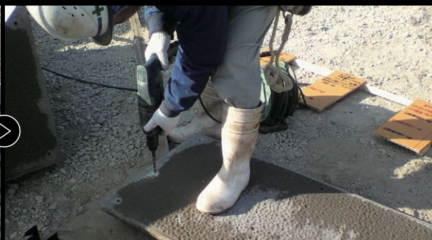
04: 補強金具取付穴加工状況
