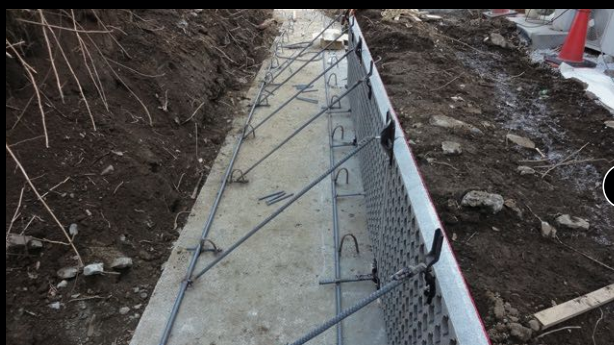
01: 1段目組立状況
